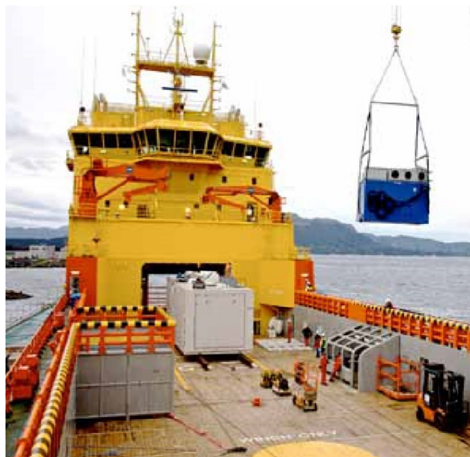
Εικόνα 45: Εγκατάσταση εξοπλισμού κυψελών καυσίμου
