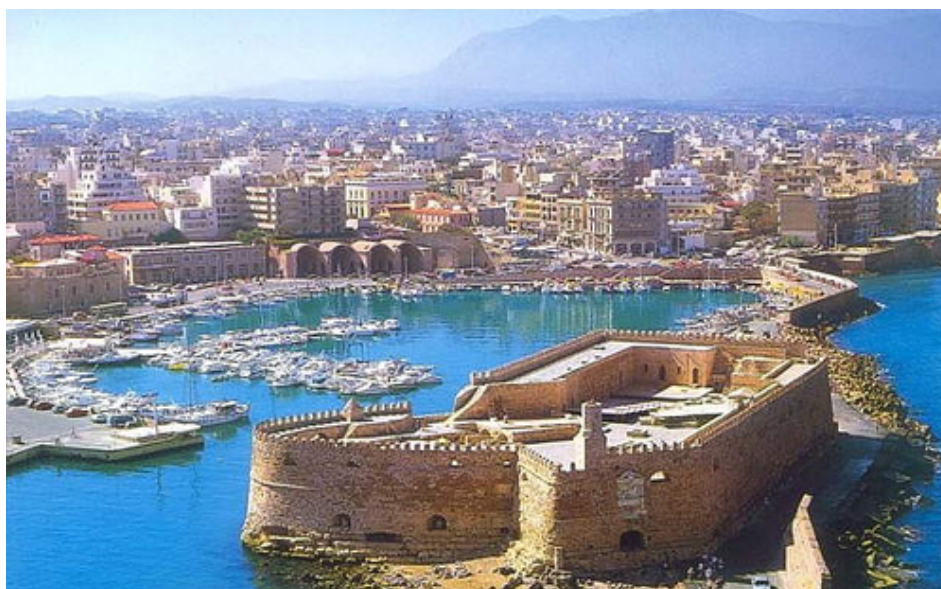
Εικόνα 51: Ενετικός λιμενοβραχίονας Ηρακλείου
